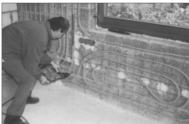
3.10. ábra. Az elkészült hálózat felerősítése a falra
