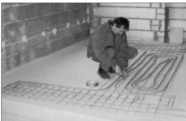
3.9. ábra. Hálózat összeszerelése a földön
