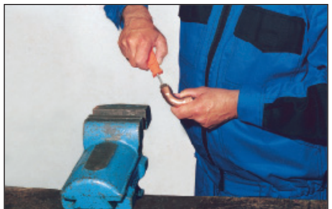
16/b. ábra Csővég- és fittingtisztítás Szerszám – tisztítókefe fittinghez
