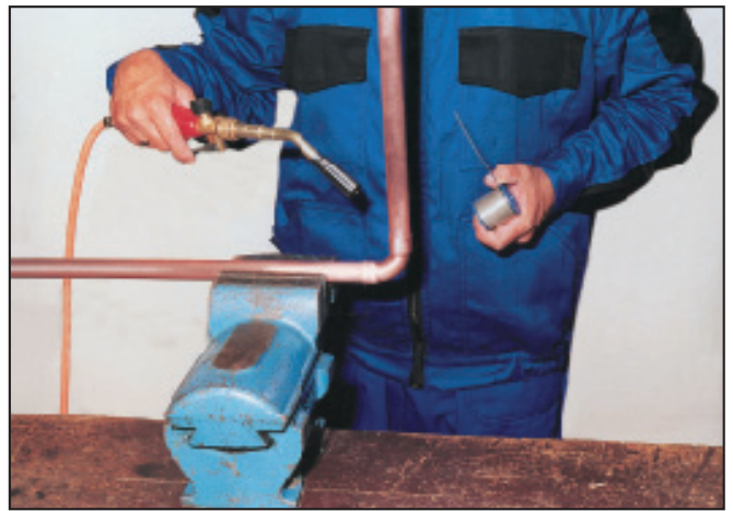
20. ábra Kötéshely melegítése
