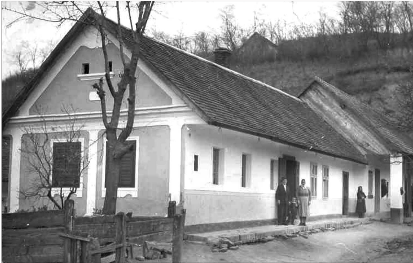
Kleines Glück mit Veranda: Die typischen Häuser der Siedler in Kalaznó waren einstöckig und mit tiefer Traufe
