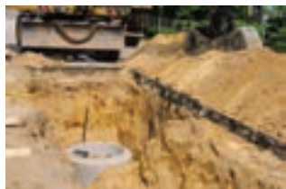
2.2. ábra Az alapozás nem csak a házépítésnél fontos
