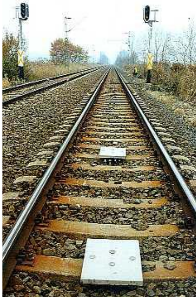
55. ábra – Kimle bejáratú jelző előtti térközjelző jelfeladói
