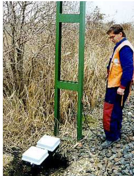
56. ábra – A jelfeladók pályamenti egységeinek telepítése
