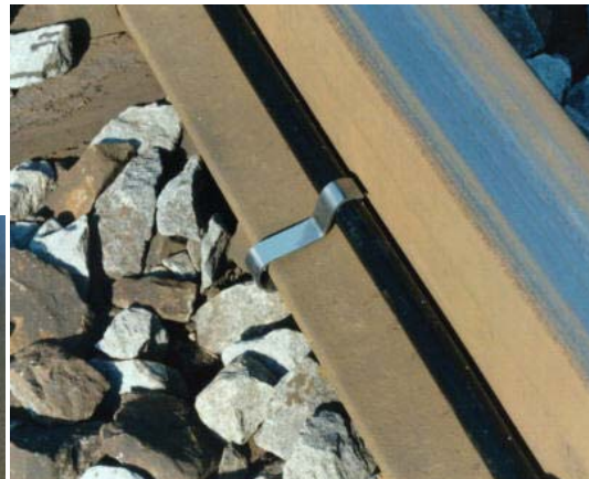
10. ábra – Euroloop (sugárzókábel) és telepítése
