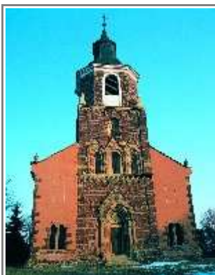
A XIII. század első felében emelt felsőörsi prépostsági templom főhomlokzata
