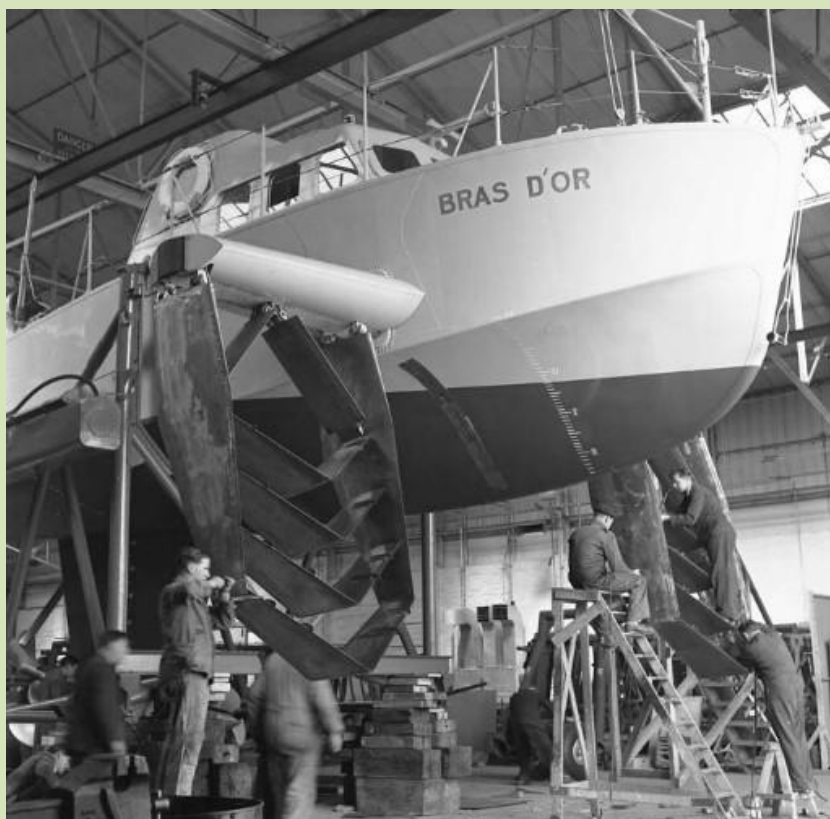
Befejezték az Monel-ötvözetből készült első „V” létraszárnyakon a munkát.
