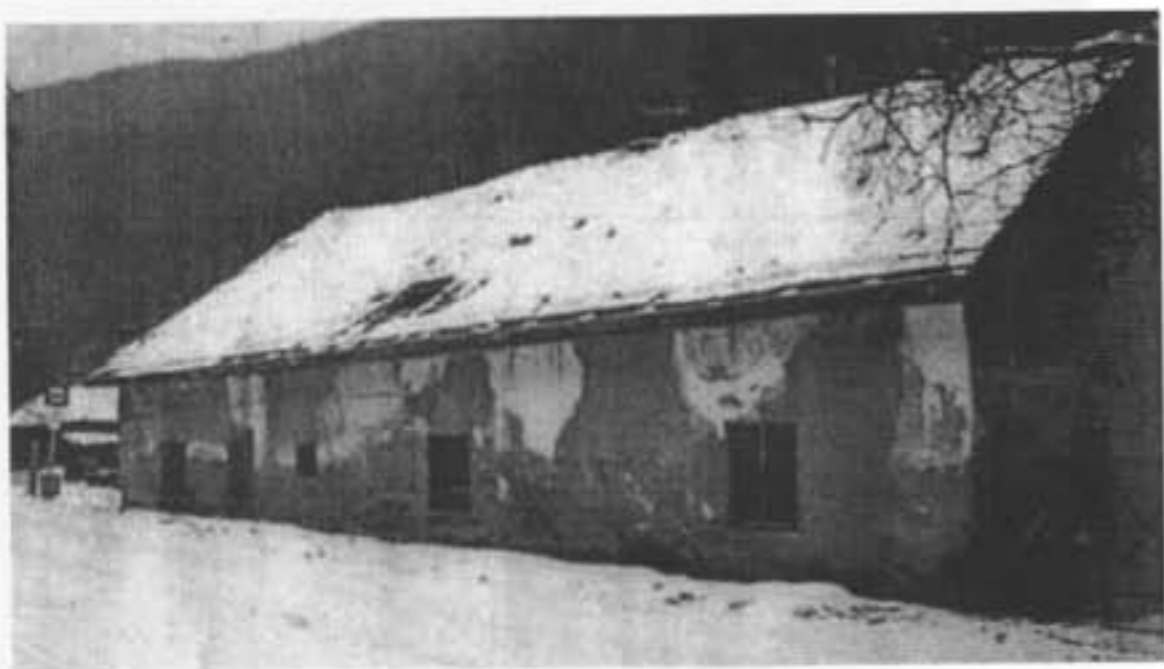
Fazola Frigyes irodaépülete és lakása, ennek falán volt az öntöttvas tábla
