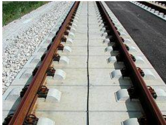
Nagy sebességű vasbeton paneles pálya
