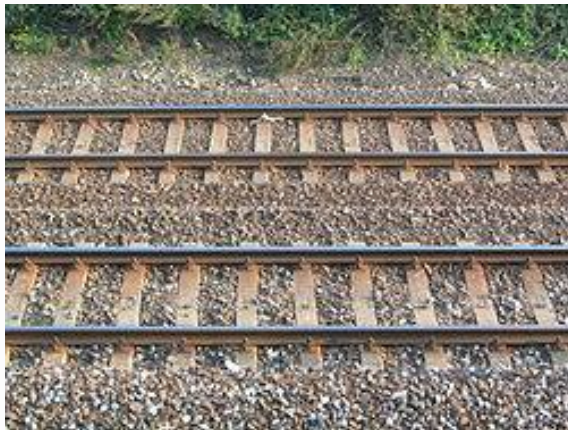
Vasbeton keresztaljas zúzottkő ágyazású pálya
